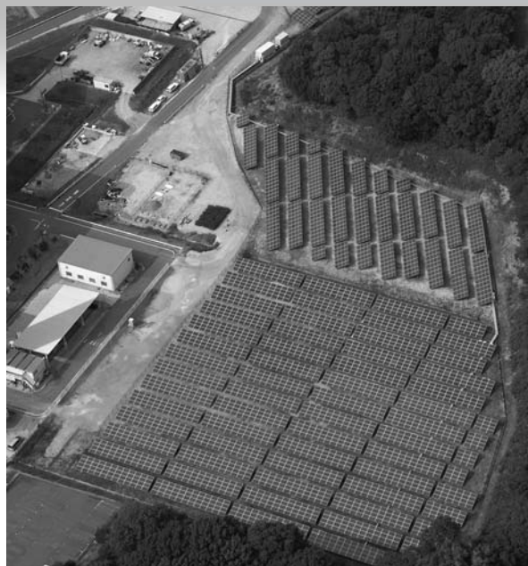
兵庫県明石市 1 MW
