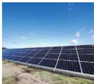
コープこうべ協同購入センター淡路では「LP156\*156-M-60」72枚を同社製の野立架台で設置。合計の発電容量は22.32kW。
