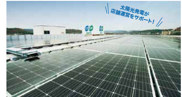
リープトンエネルギー製パネルを採用し、太陽光発電による自家消費を行っている「コープデイズ神戸西店」。屋上出力360Wのパネルが440枚設置されており、合計の発電容量は158.4kW。
