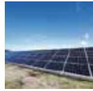
コープこうべ西園購入センター設置では、LP156*156-M-72が採用された。132枚合計で発電容量は47.52kW。
