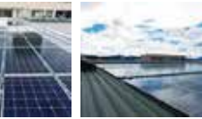
コープデイズ豊岡店では、LP156*156-M-72が576枚設置されており、合計の発電容量は207.36kW。
