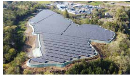
綾部市位田町松前太陽光発電所 2.1MW
