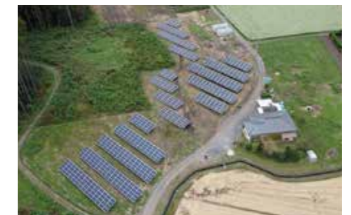
茨城県那珂飯田I太陽光発電所 100.8kW
