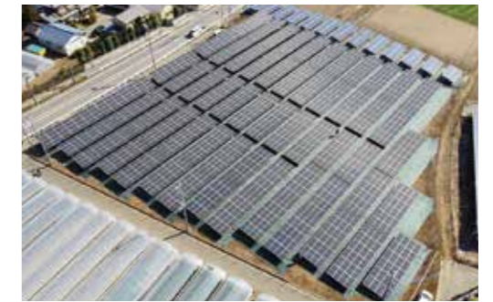
野田木間ヶ瀬太陽光発電所 642.88kW
