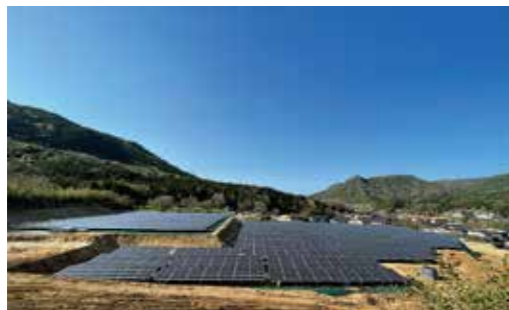
山口県下小鯖太陽光発電所 974.7kW
