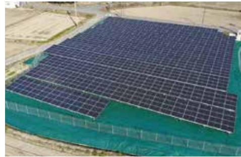
加西市福住太陽光発電所 302.6kW
