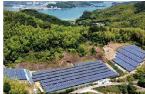
阿波福井太陽光発電所 698.88kW
