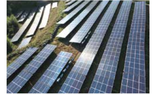
美里白石太陽光発電所 580.32kW
