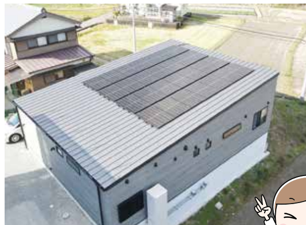
和歌山県／11.2kW 使用パネル：LP182*182-M-54-MH-410W 28枚
