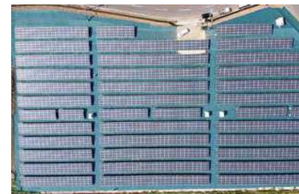
長崎県田平町太陽光発電所 1.03MW
