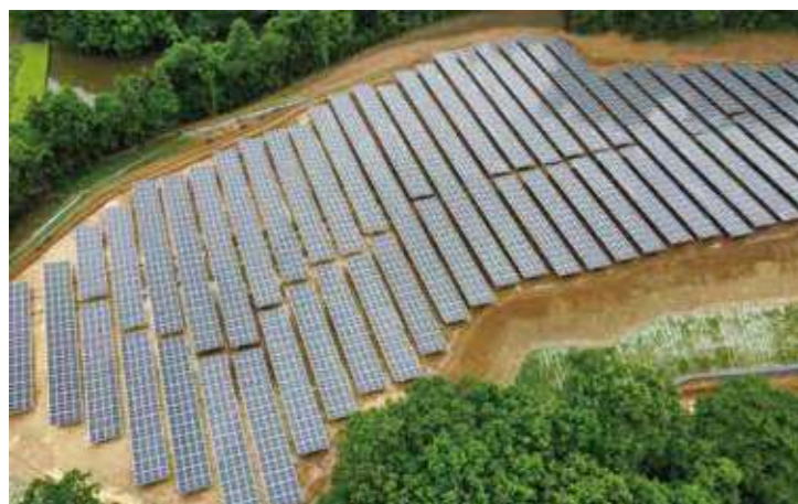
滑川町山田太陽光発電所 1.87MW
