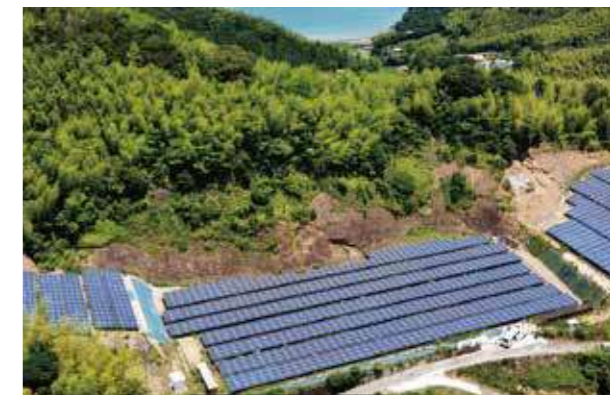
阿波福井太陽光発電所 698.88kW
