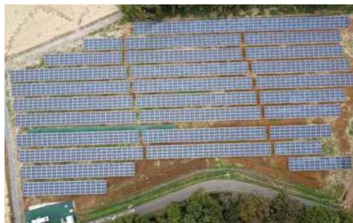
茨城県茨城町太陽光発電所 1MW
