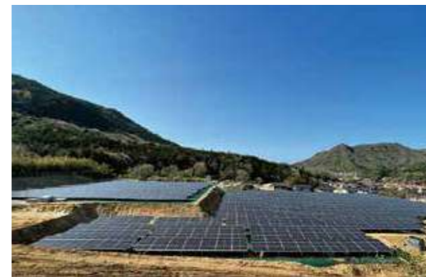
山口県下小鯖太陽光発電所 974.7kW
