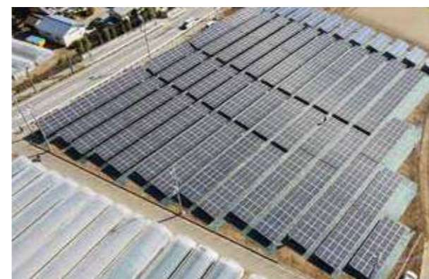
野田木間ヶ瀬太陽光発電所 642.88kW
