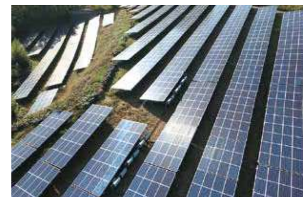
美里白石太陽光発電所 580.32kW
