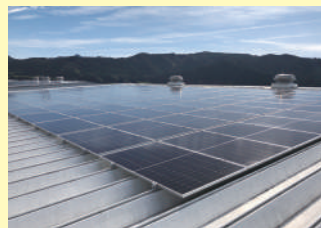
工場屋根・敷地
