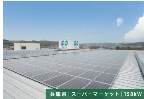
兵庫県 | スーパーマーケット | 158kW
