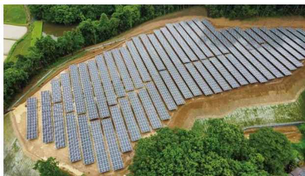
埼玉県滑川町山田太陽光発電所 (設備容量 : 1,870kW)
