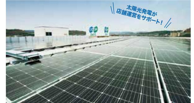
リープтонエネルギー製パネルを採用し、太陽光発電による自家消費を行っている「コープデイズ神戸西店」。屋上に出力360Wのパネルが440枚設置されており、合計の発電容量は158.4kW。
