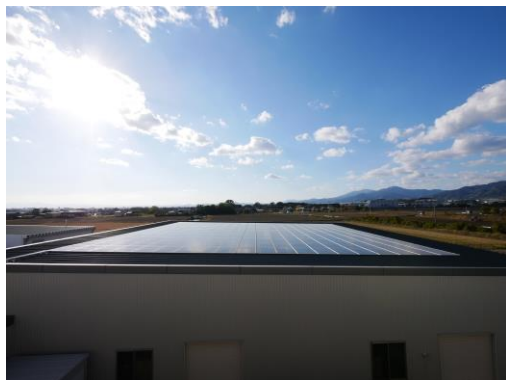
工場屋根・敷地
