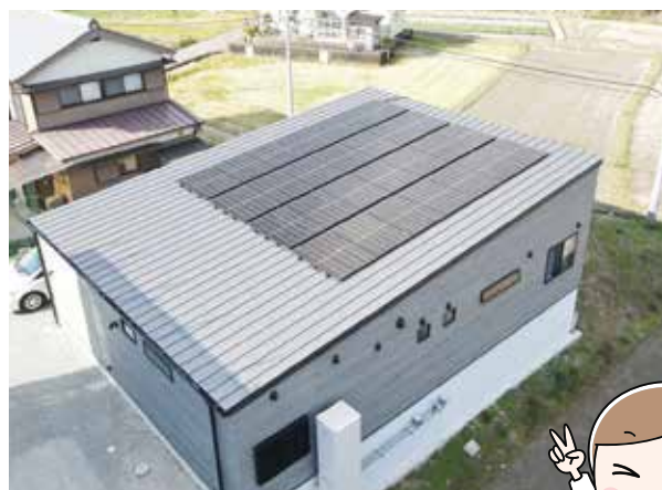
和歌山県／11.2kW 使用パネル:LP182*182-M-54-MH-410W 28枚
