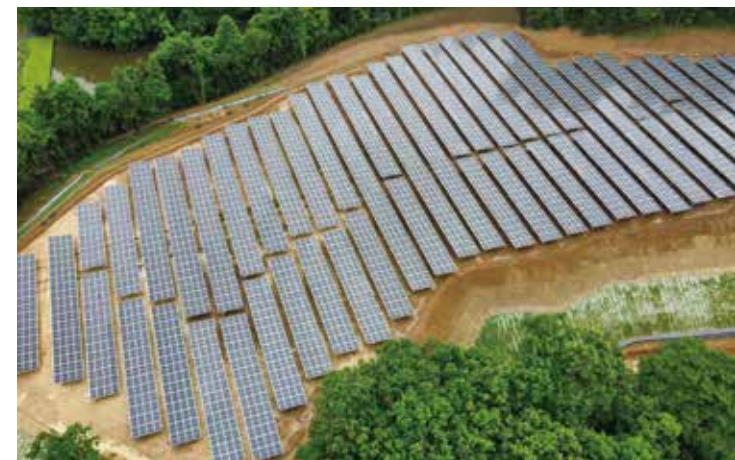
滑川町山田太陽光発電所 1.87MW
