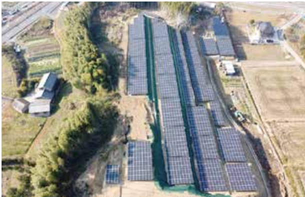
愛知県阿久比太陽光発電所 806.4kW
