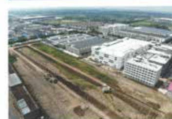
8月にパネル新工場の第2期工事に着手した
