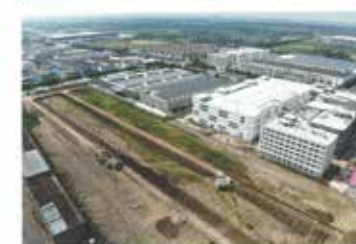
8月にパネル工場第2期工事に着手した
