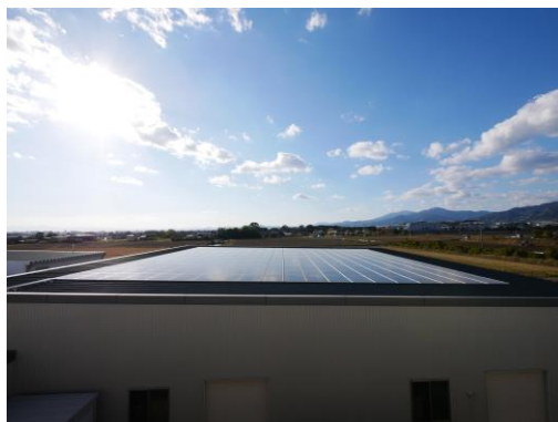
工場屋根・敷地
