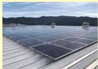
工場屋根・敷地
