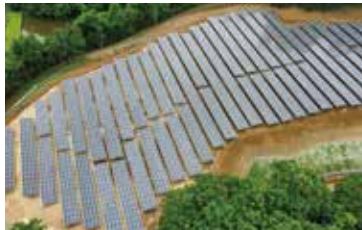
滑川町山田太陽光発電所 1.87MW
