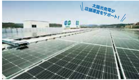
リープтонエネルギー製パネルを採用し、太陽光発電による自家消費を行っている「コープエナジー神戸西店」。屋上に出た3500㎡のパネル440枚が設置され、自社の消費電量は158.4kW。
