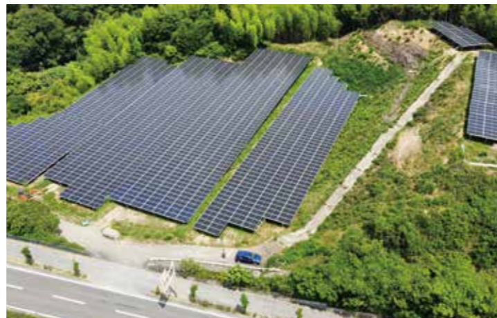
淡路市岩屋字桑ノ木谷発電所 1.09MW
