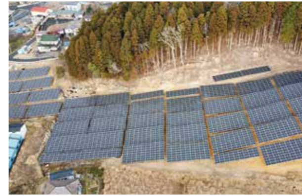
LP宮城県石巻太陽光発電所 1.35MW
