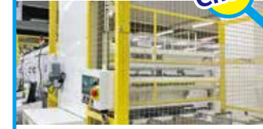
耐電圧、絶縁抵抗、接地抵抗など電気安全試験を行います。
