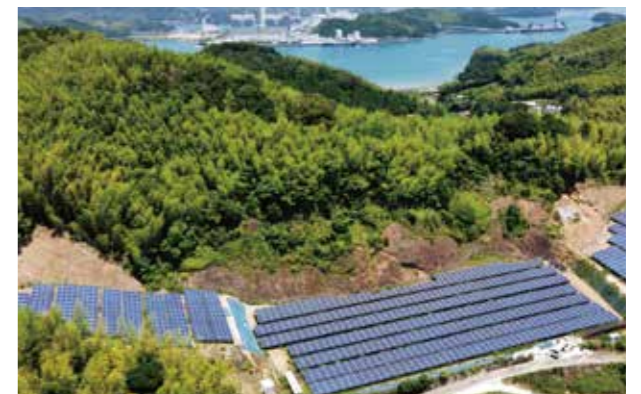
阿波福井太陽光発電所 698.8kW
