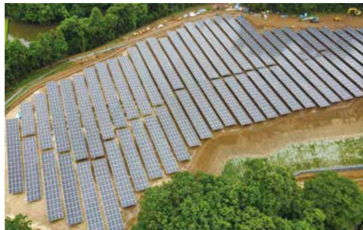
滑川町山田太陽光発電所 1.87MW
