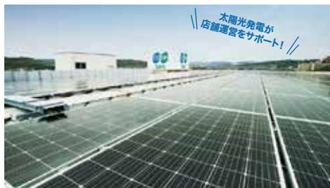
リープтонエネルギー製パネルを採用し、太陽光発電による自家消費を行っている「コープダイオ神戸西店」。屋上に出た3500Wのパネル440枚が設置されており、自社の消費電量は158.4kW。
