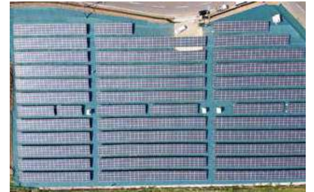
長崎県田平町太陽光発電所 1.03MW
