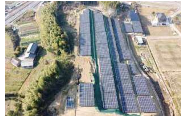
愛知県阿久比太陽光発電所 806.4kW
