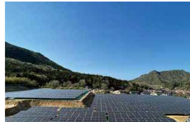
山口県下小鯖太陽光発電所 974.7kW
