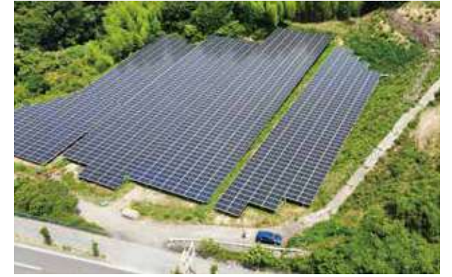
淡路市岩屋字桑ノ木谷発電所 1.09MW
