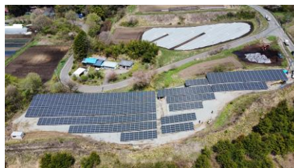
兵庫岩屋発電所 | 1MW
