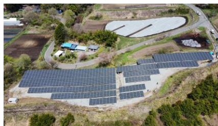
兵庫岩屋発電所 | 1MW
