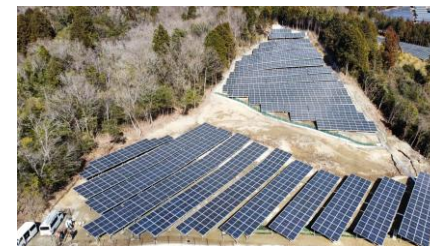
滋賀甲賀発電所 | 651.9kW
