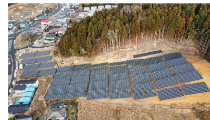
宮城石巻発電所 | 1.3MW
