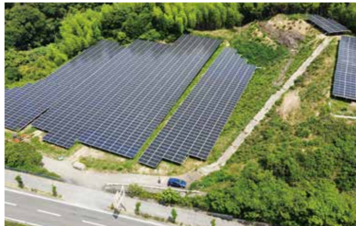
淡路市岩屋宇桑ノ木谷発電所 1.09MW
