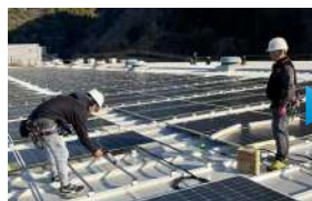
①コーキング材の塗布
