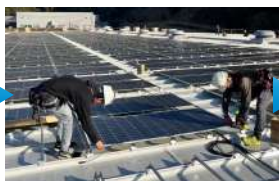
③モジュールの貼付
