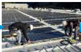
③モジュールの貼付
