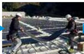
②モジュールの運搬
