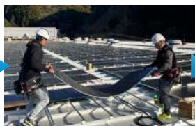
②モジュールの運搬
