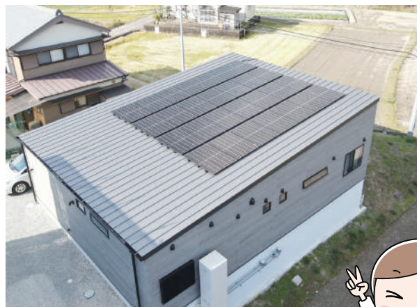
和歌山県／11.2kW 使用パネル:LP182*182-M-54-MH-410W 28枚
