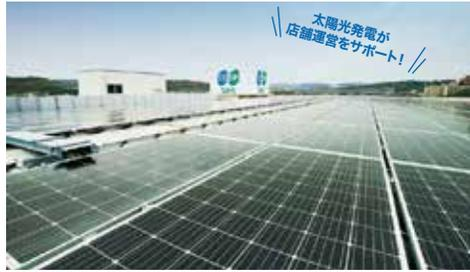
リープтонエネルギー製パネルを採用し、太陽光発電による自家消費を行っている「コープエナジー神戸店」。屋上に出る3500Wのパネル440枚が設置され、自社の消費電量は158.4kW。
