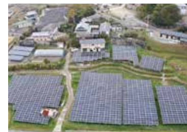
兵庫石田発電所 | 601.8kW
