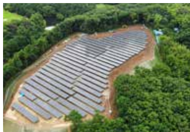
埼玉滑川発電所 | 1.8MW
