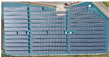
長岡県田平町太陽光発電所 1.03MW
