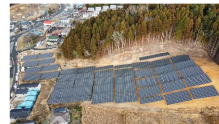
宮城石巻発電所 | 1.3MW
